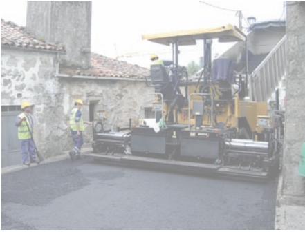
➔ Un finisseur à chaînes AP655D pour des travaux de toutes tailles.
